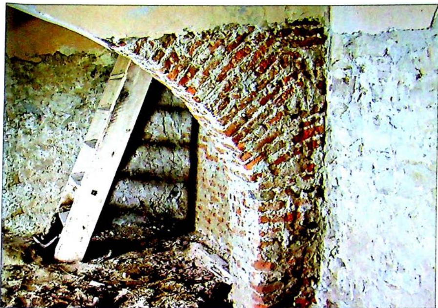
A 2003-as nagyjavítási munkák során feltárt boltív
